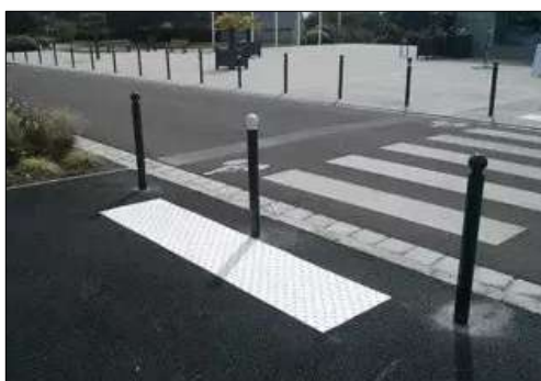
Dalle podotactile avec bordure abaissée Source : CEREMA
