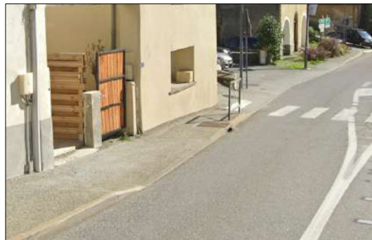
Accès rétabli avec mise en place de bateaux Source : Google Street View
