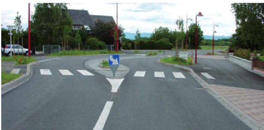
Exemple de chicane en sortie d'agglomération Source : CEREMA
